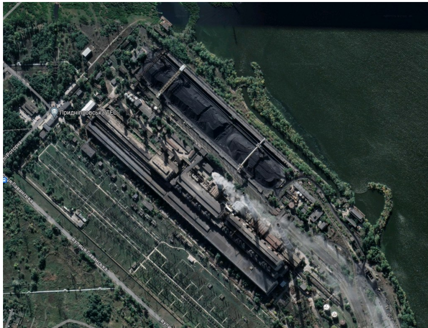
Рисунок 2.3 – Придніпровська ТЕС на Google Maps
