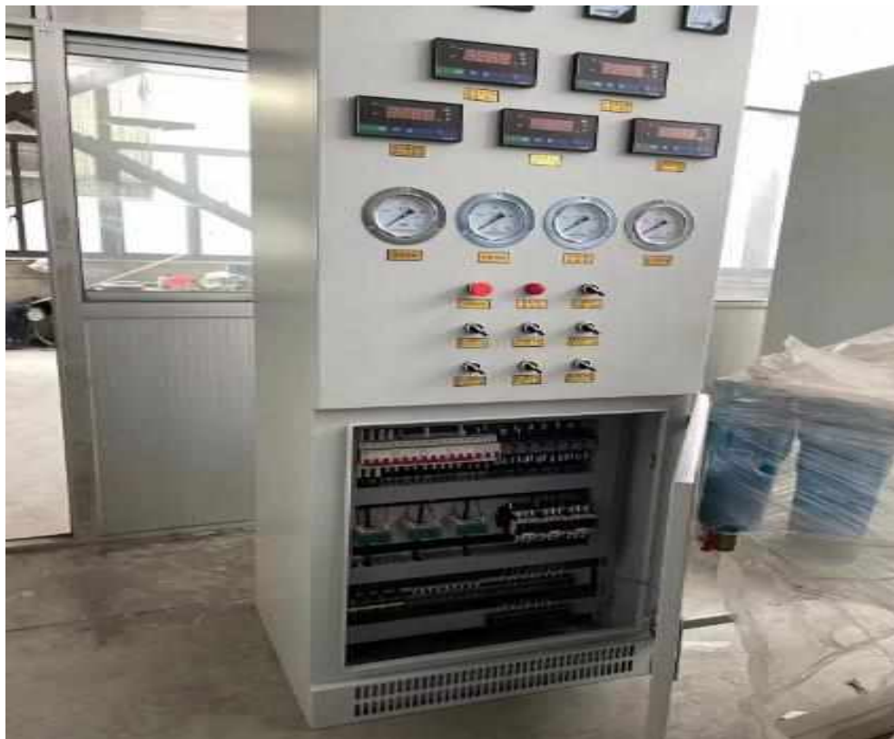
Рисунок 3.8 – Технологічний вузол підтримки тиску газоподібного кисню
