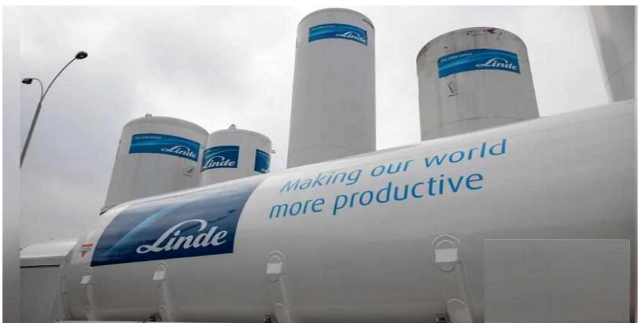
Рисунок 3.4 – Резервуар для зберігання кисню
