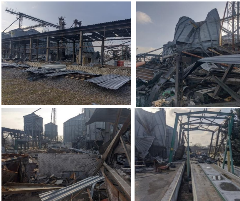
Рисунок 1.1 – Фотофіксація зруйнованої території елеватора в с. Кільчень внаслідок збройної агресії рф
