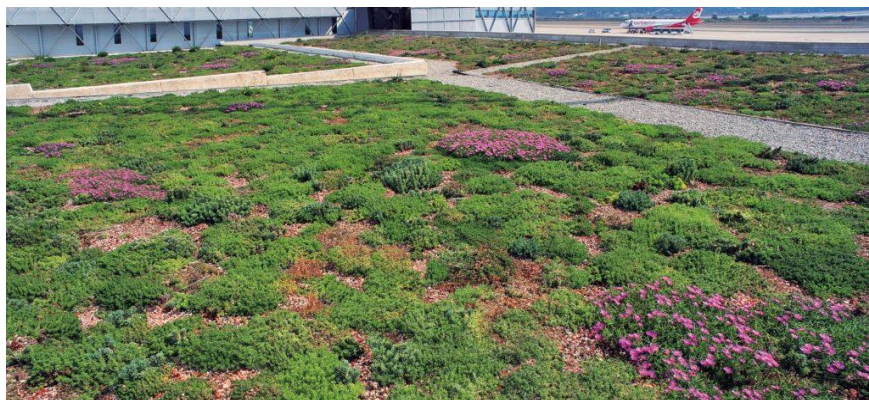
Рис. 2.42 – Приклад зеленої покрівлі екстенсивного типу ( www.zinco-greenroof.com )
