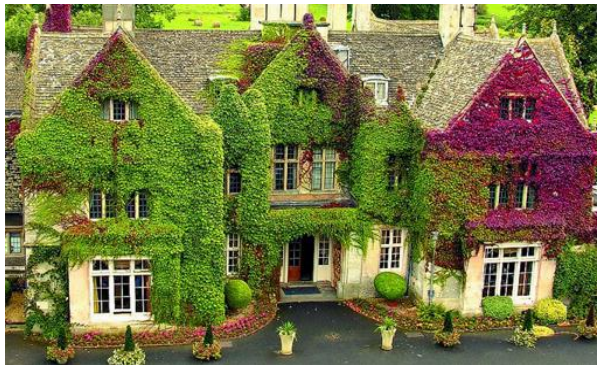
Рис. 2.48 – Вертикальне озеленення фасаду «Greenway», Англія ( https://rubryka.com/article/vertical-garden/amp/ )
