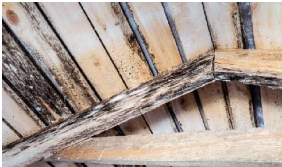
Рисунок 1.2 – Вплив вологості середовища на деревину (утворення плісняви)
