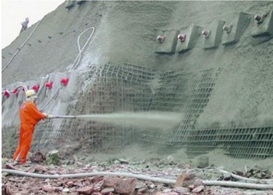
Рисунок 2.25 – нанесення бетонної суміші при торкретуванні
