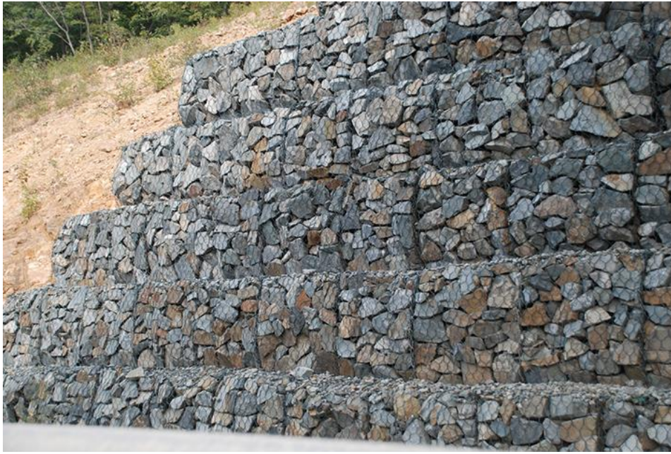
Рисунок 2.22. – габіонна конструкція
