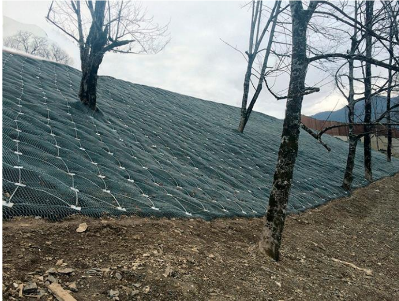
Рисунок 2.26 – використання полімерних і металевих сіток
