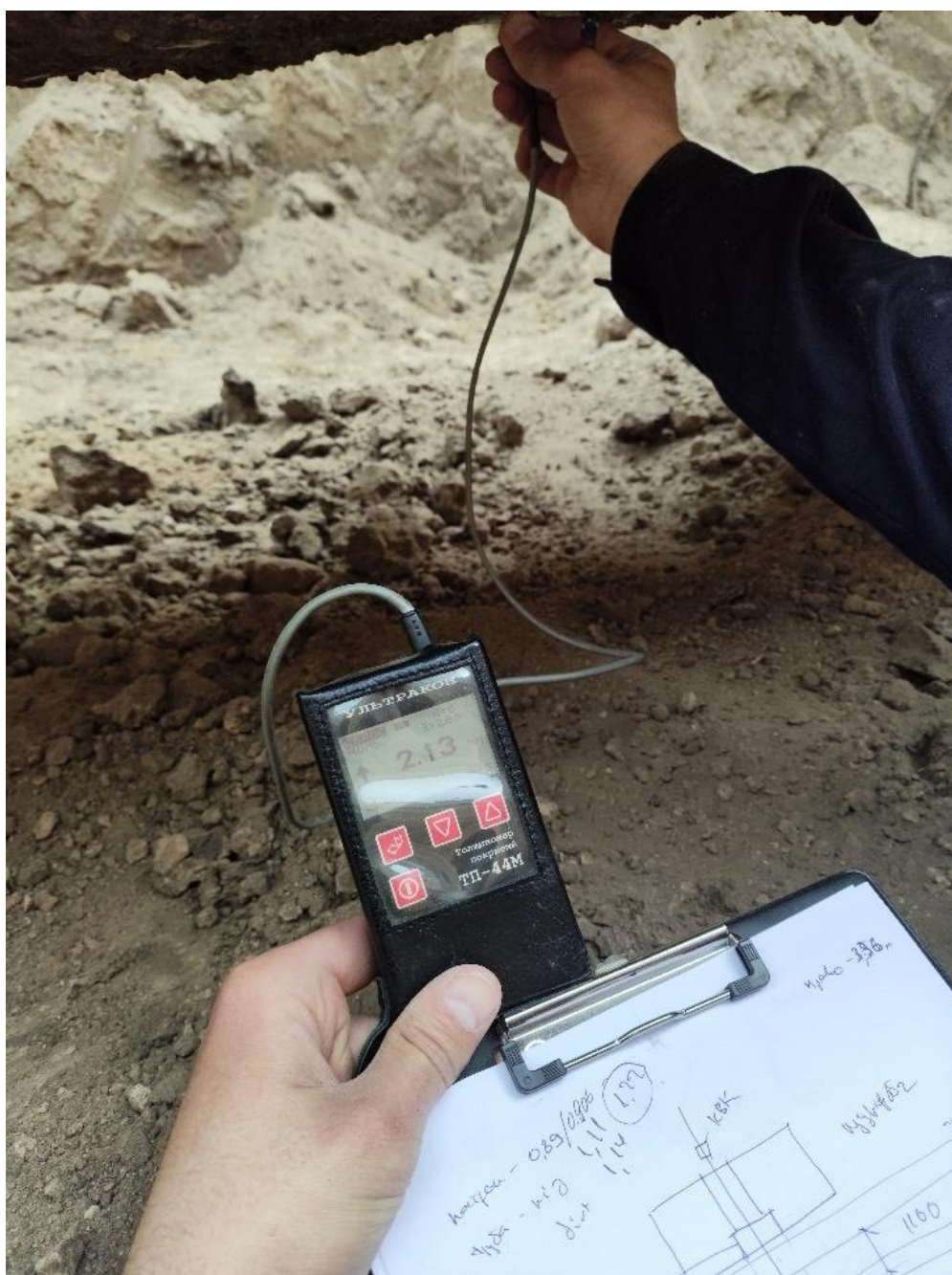
Рис. 3. Обстеження технічного стану трубопровідної конструкції
