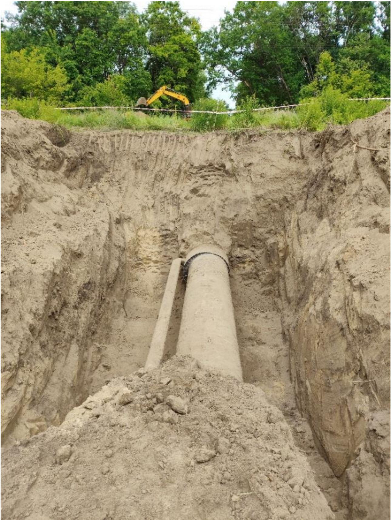
Рис.2. Шурф № 1 для візуально-вимірювального контролю та інших досліджень
