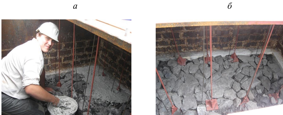
Рисунок 5.7 – Загальний вигляд процесу монтажу реперних датчиків: a – візуалізація монтажу реперних датчиків; б – позиціювання реперних датчиків у гірському масиві
