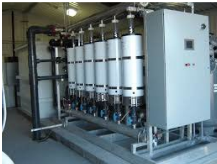
Рисунок 1.8 – Вигляд ультрафільтраційного фільтру [8]
