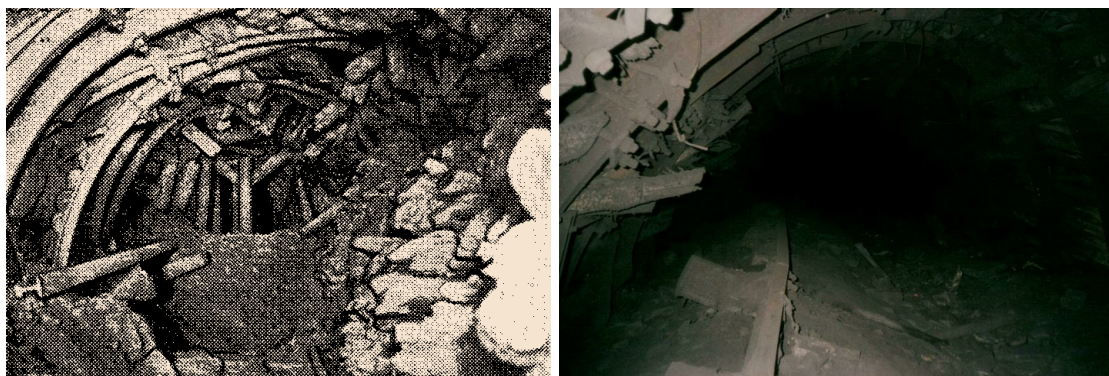
Рис. 4.4. Стан вентиляційних штреків у зоні впливу очисних робіт
