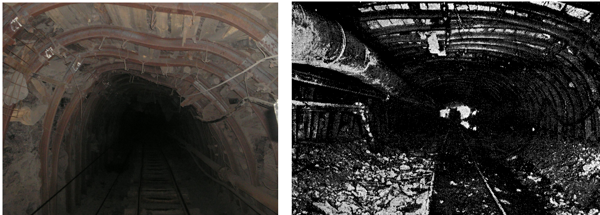
Рис. 2.7. Деформація кріплення КШПУ із спецпрофілю і коробовим склепінням
