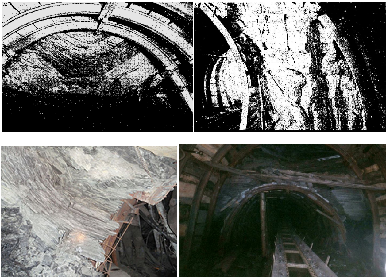
Рис. 9.19. Характер тріщинуватості порід навколо виробки
