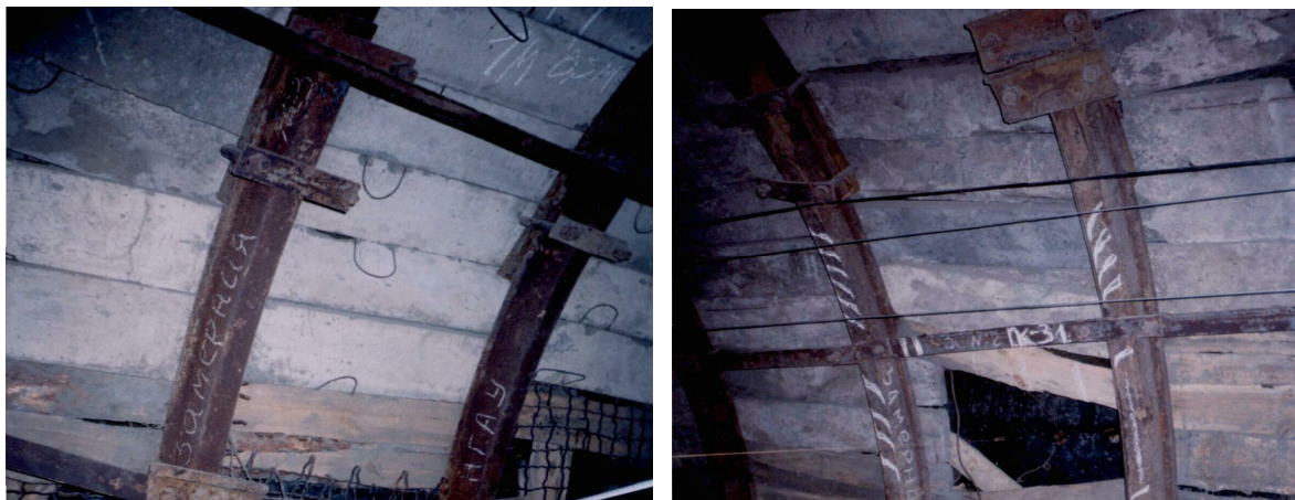
Рис. 2.43. Забутований закріпний простір
