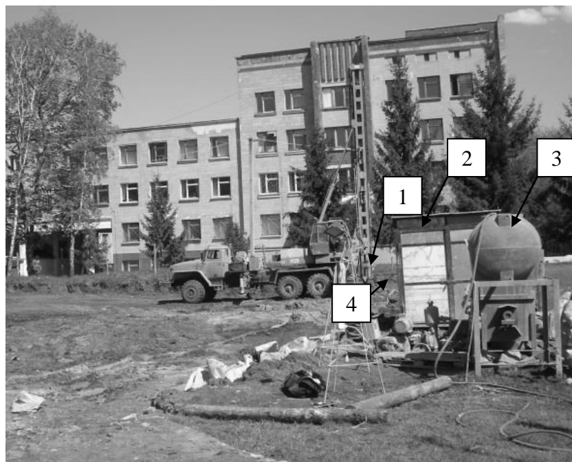
Рис. 6.7. Комплект обладнання для влаштування ґрунтоцементних елементів бурозмішувальним методом: 1 – буровий верстат; 2 – розчиномішалка і розчинонасос; 3 – ємність для води; 4 – напірний шланг
