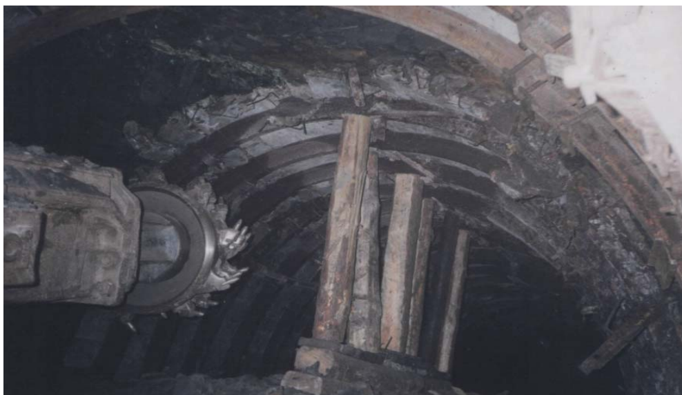
Рис. 4.21. Повторное перекрепление 115-ого бортового штрека с выемкой пород почвы (1,0...1,2 м) проходческим комбайном
