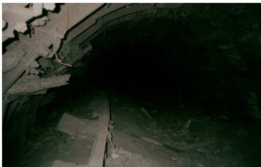
Рис. 4.20. Состояние 115-ого бортового штрека после перекрепления а) забой перекрепления; б) 100 м за лавой; в) 250 м за лавой
