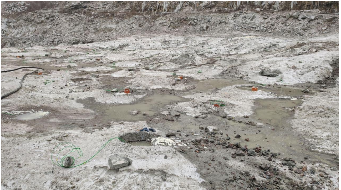
Рис. 3.3 – Заряджені свердловини вибухового блоку
