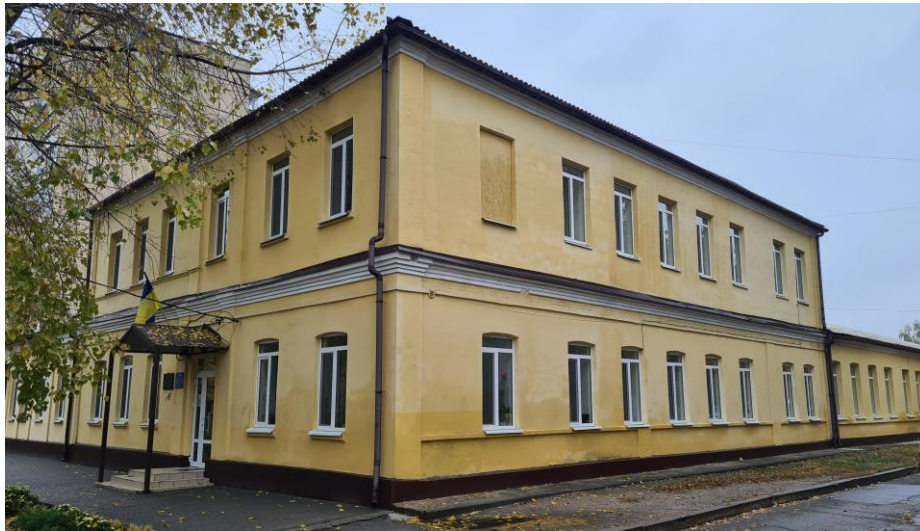
Рисунок 2.1 – Загальний вид досліджуваної будівлі
