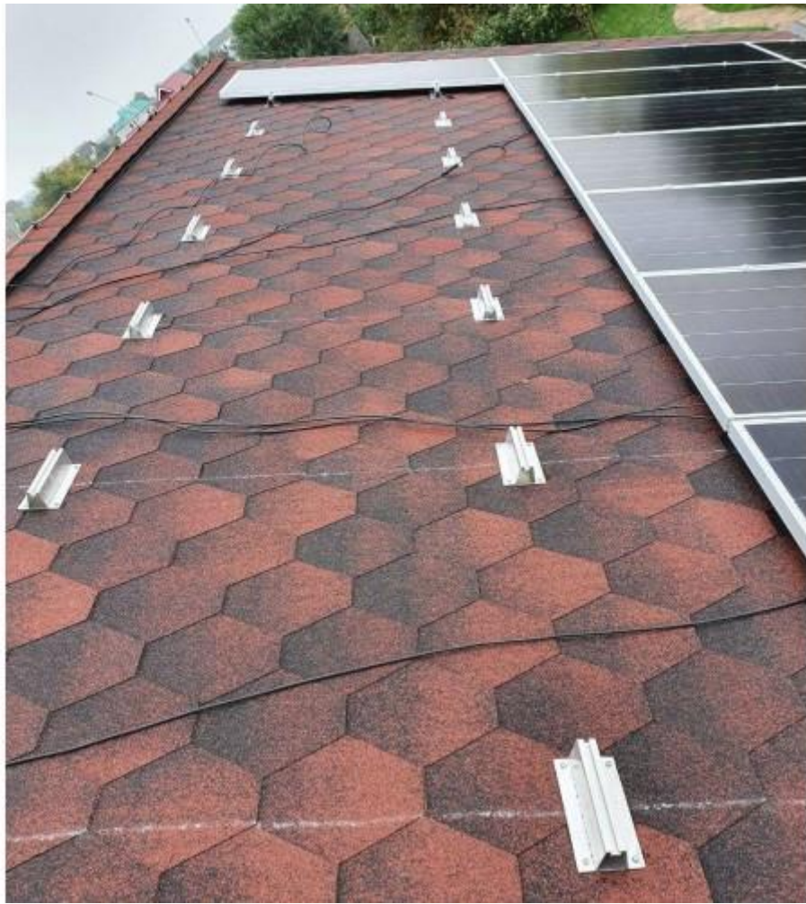
Рисунок 11. Алюмінева опора встановлена на покрівлі будинку
