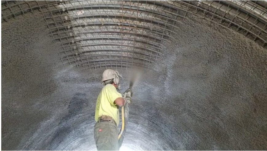
Рис. 2.3 – Нанесення торкрет-бетону
