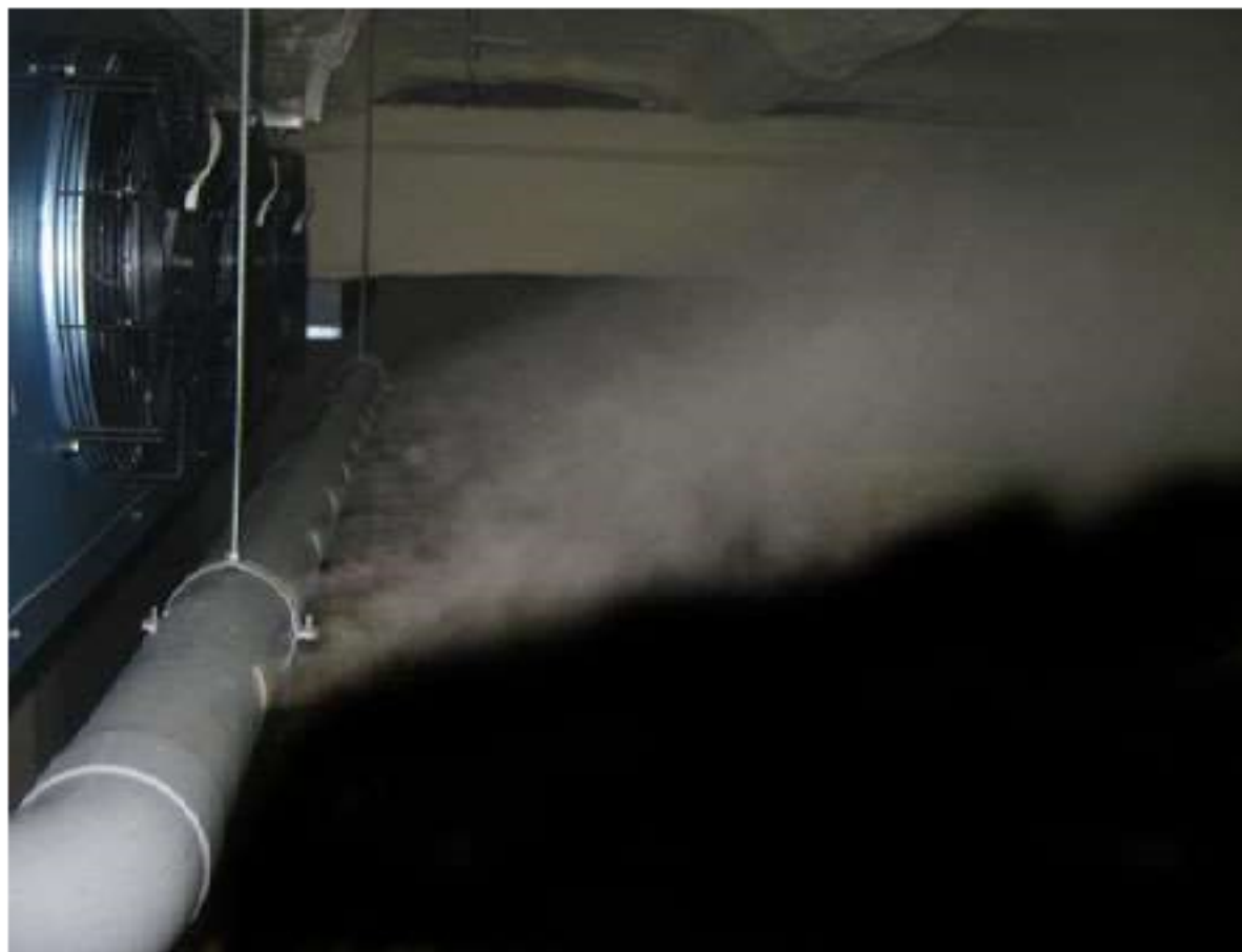
Рис. 3.3 Приклад типової схеми роботи установки для зволоження повітря
