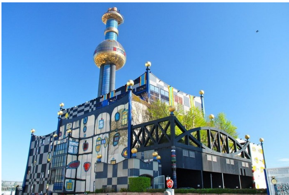
Рис. 2.5 – Сміттєспалювальний завод в Японії. Будівля виглядає дуже незвичайно всередині та зовні, нагадує казковий замок. При ньому функціонує музей, центр реабілітації інвалідів, готель та ресторан
