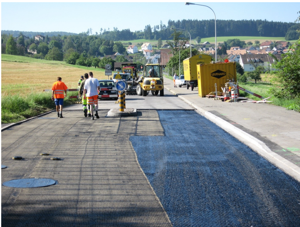
Рис. 2.4 – Укладання гласасфальту
