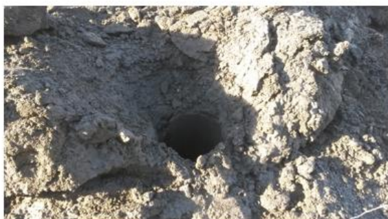
Рисунок 2.2 – Гирла свердловин після шарошечного буріння
