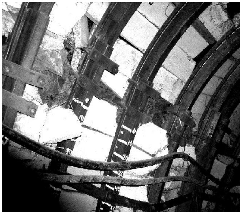
Рисунок 1 – Деформации железобетонных затяжек
