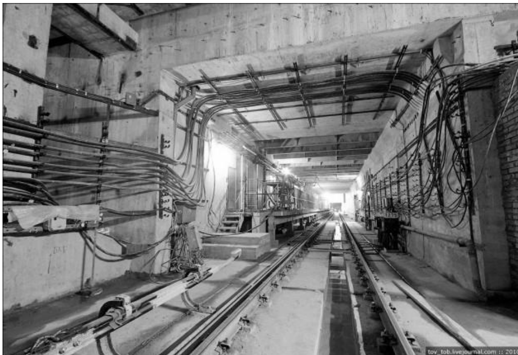
Рис. 3. Использование метода «стена в грунте» при строительстве односводчатых станций
