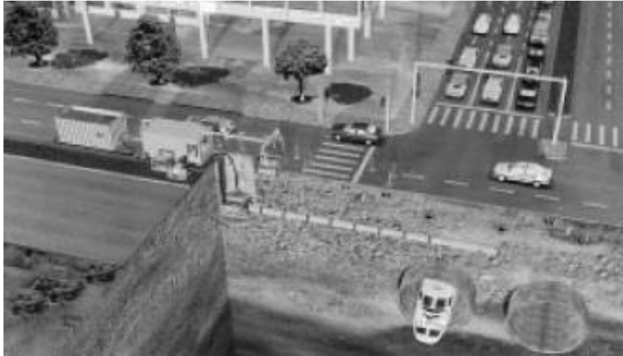
Рис. 1. Безтраншейна прокладка трубопроводу з застосуванням мікропрохідницького комплексу
