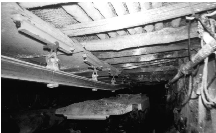
Рис. 1. Демонтажная камера ш. «Богданка». Крепление монорельса к перекрытиям механизированной крепи.
