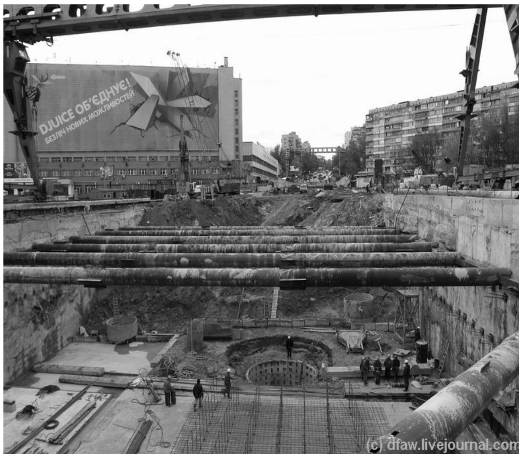
Рис. 4. Строительство станции метро Демеевская
