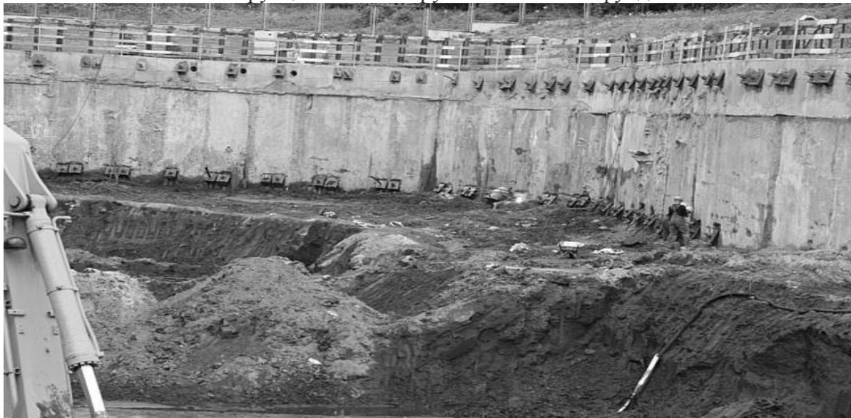
Рис. 1. Стена в грунте
