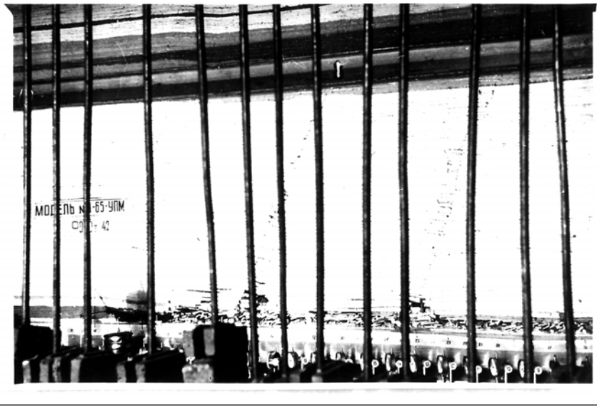
Рисунок 2.3 - Характер обрушения пород кровли
