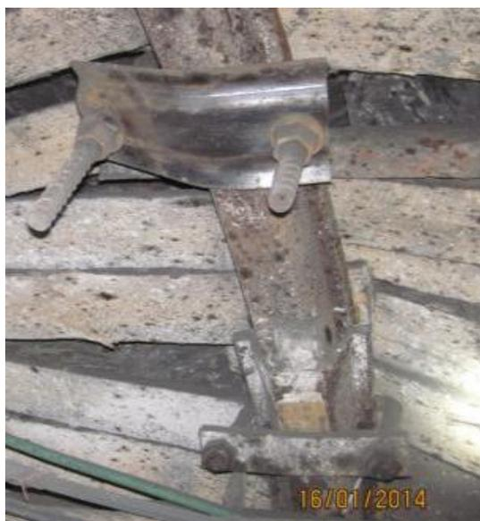
*Рис. 3. Усиление крепи спаренными анкерными подхватами под верхняк*
