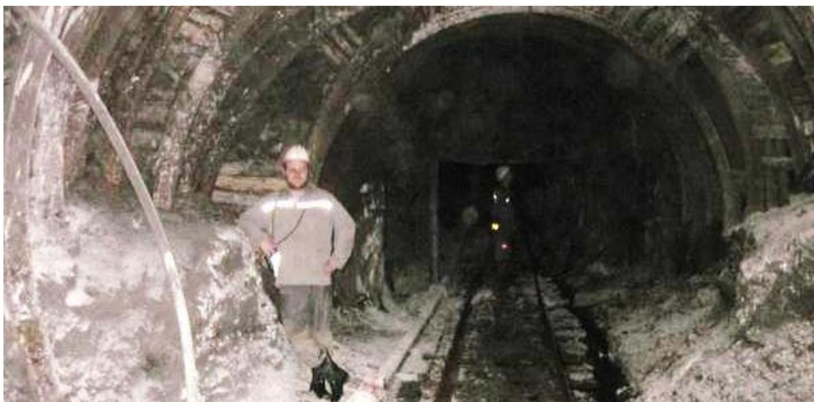
*Рис. 5. Подрывка пород почвы на участке дренажного штрека*
