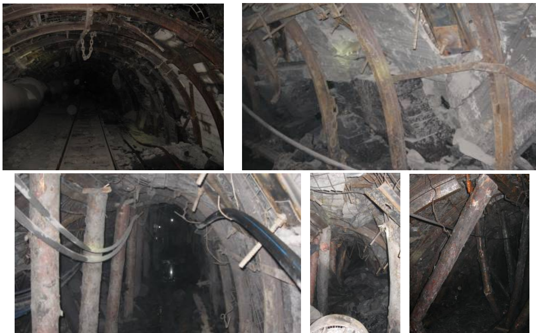
Рис. 8.4. Характер тріщинуватості порід навколо виробки
