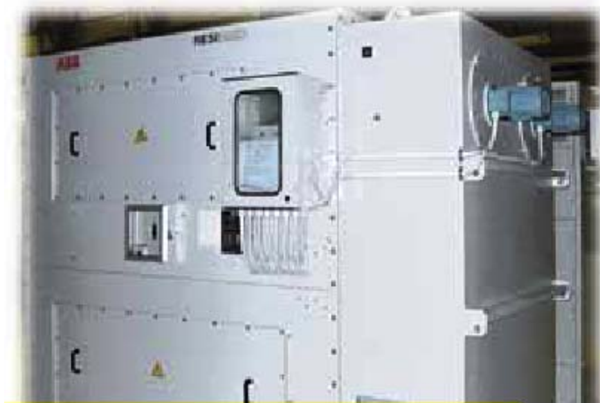
Рисунок 4.8 – Трансформатор з повітряно-водяним охолодженням IP 54 виконаний для потреб гірничої промисловості
