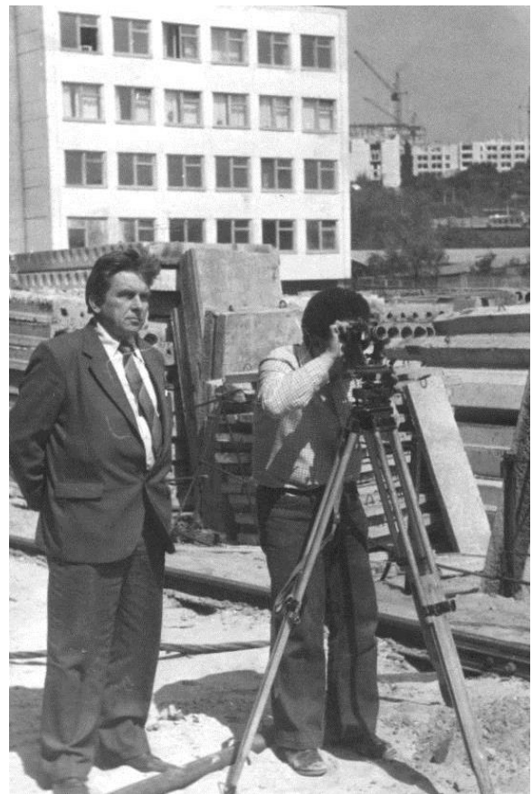
Рева С.Н. – на строительстве военной кафедры. 1985 г.
