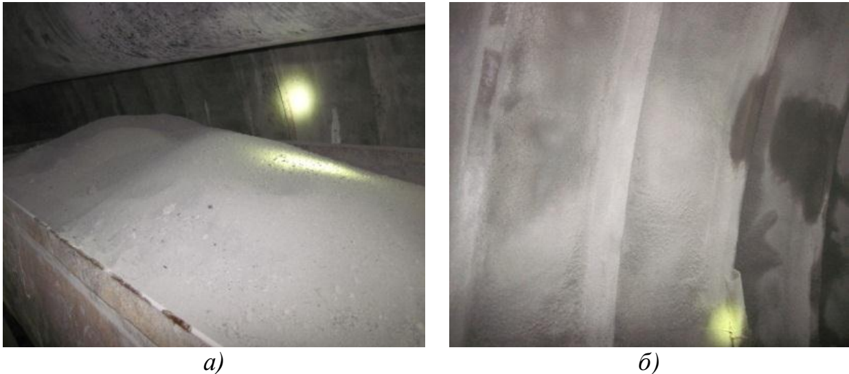
Рис. 9. Елементи виконання робіт зі зведення арочного кріплення з використанням розроблених рецептур твердіючих сумішей для тампонажу закріпного простору: а – вагонетка із подрібненою породою; б – торкрет-бетонне покриття із твердіючою сумішшю на основі вуглевміщуючих порід, нанесене на поверхню металевого рамного кріплення з залізобетонною затяжкою
