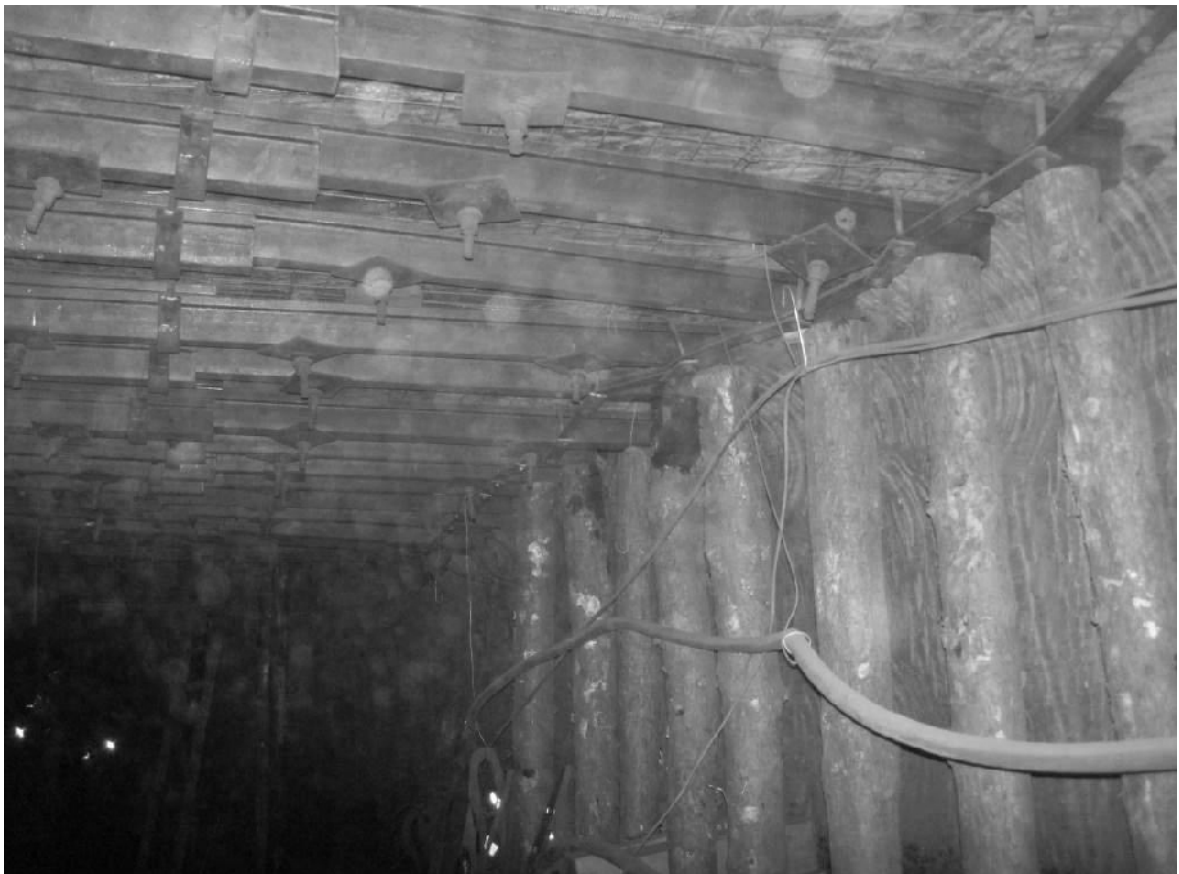
Рис. 3.12. Состояние демонтажной камеры 161-й лавы при ее проведении
