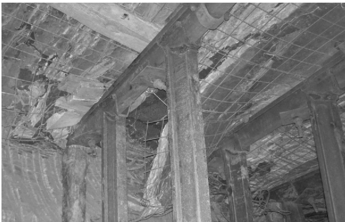
Рис. 3.13. Кровля демонтажной камеры 161-й лавы при ее проведении
