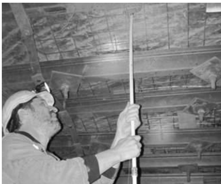
Рис. 3.8. Установка якоря в скважину
