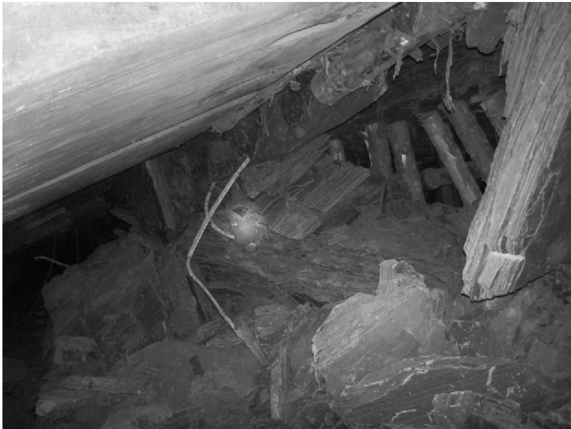
Рис. 3.15. Подход секций механизированной крепи в демонтажную камеру
