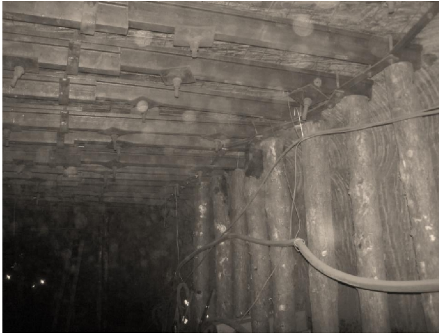
Рис. 3.3. Вид крепи демонтажной камеры
