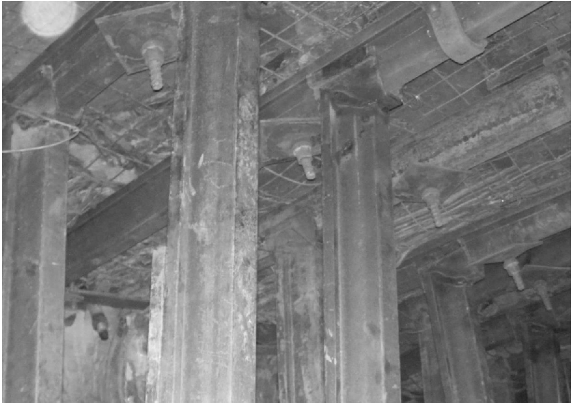
Рис. 3.11. Металлические стойки усиления демонтажной камеры 161-й лавы
