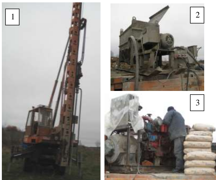
Рис. 5.12. Комплект обладнання для цементації за бурозмішувальною технологією: 1 – бурова машина; 2 – розчинозмішувач; 3 – розчинонасос
