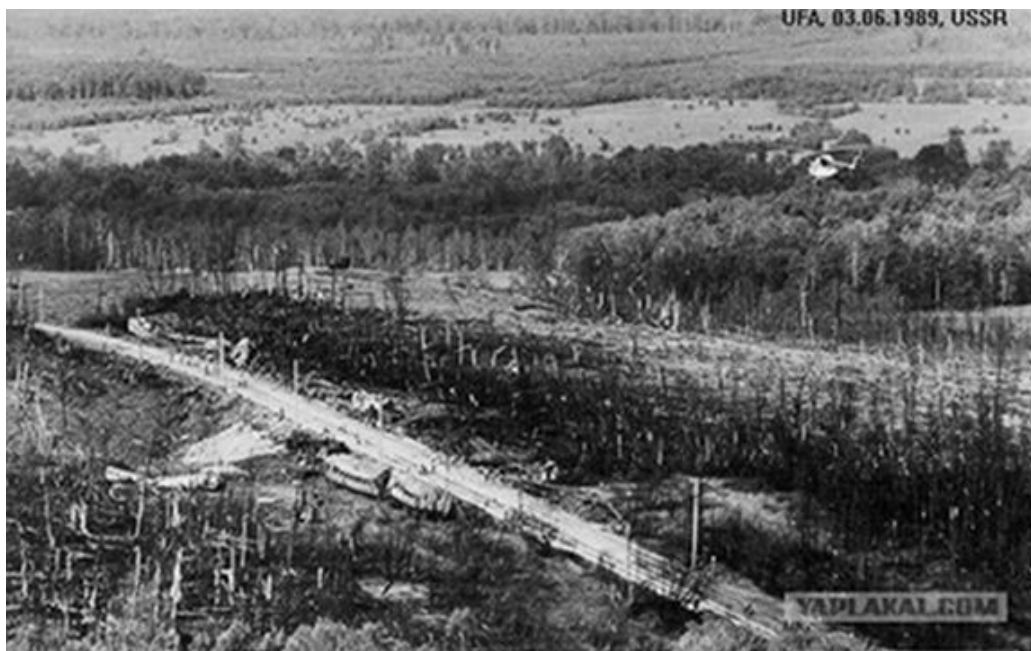
Рис.4. Наслідки вибуху витоку газу із трубопроводу біля залізниці під Уфою (1989 рік).
