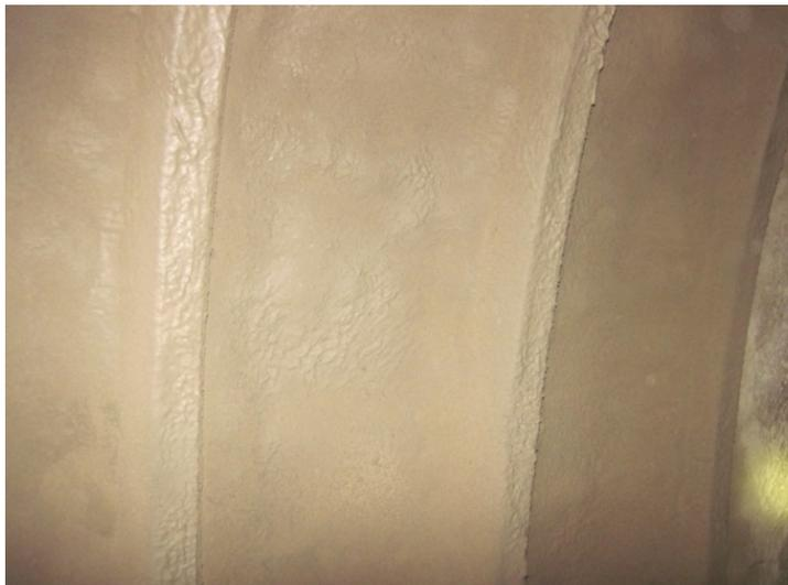
Рис. 4. Вид торкрет-бетонного покрытия на основе измельченной породы взамен части песка
