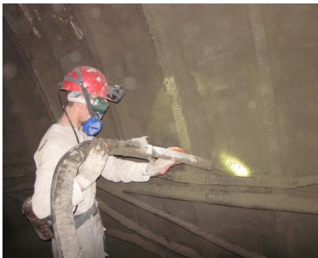
Рис. 3. Процесс нанесения торкрет-бетонного состава с породным наполнителем
