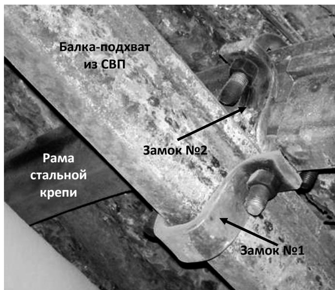
Рис. 2. Пример жесткого соединения балки-прогона из спецпрофиля СВП с рамой стальной крепи
