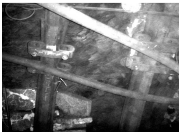
Рис. 3. Состояние замковых соединений крепи выработки, оснащенных стабилизаторами, после прохода лавы
