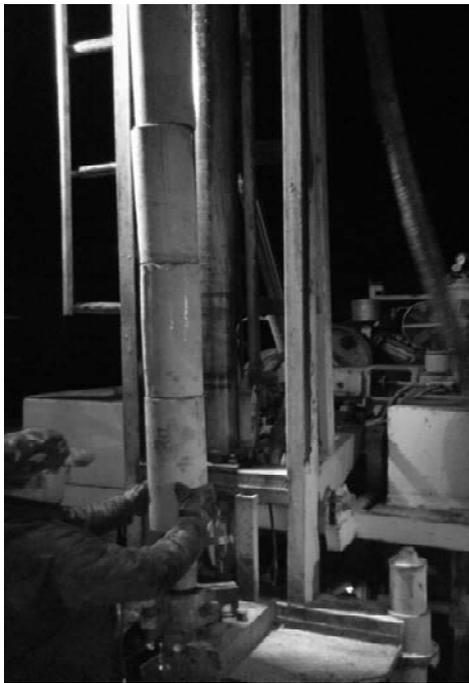
Рис. 3. Спуск КГФ в скважину
