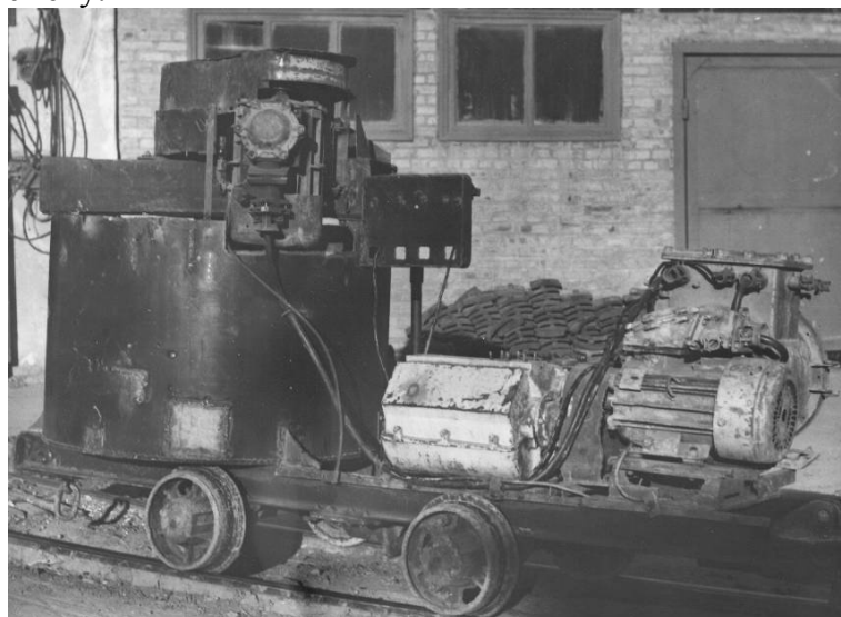
Рис. 8. Установка УМБ (установка мокрого бетонирования),
