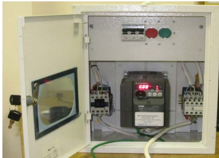
Рисунок 2 - Зовнішній вигляд щита керування електроприводом механізму підйому вантажу
