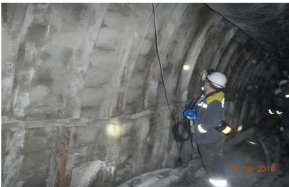
Рис. 4. Состояние 1-го западного магистрального конвейерного штрека г. 370 м ш-ты им. Героев космоса, проведенного с тампонажем закрепного пространства
