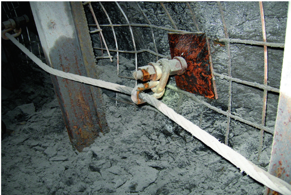
Рисунок 2.3 – Примеры поддержания выемочных штреков рамно-анкерной крепью и варианты механических связей анкеров и стоек рамы, объединенных в единую грузонесущую конструкцию
