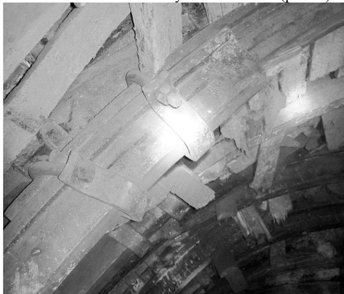
Рис. 1. Перекос скоб в замковом соединении ЗПКм
