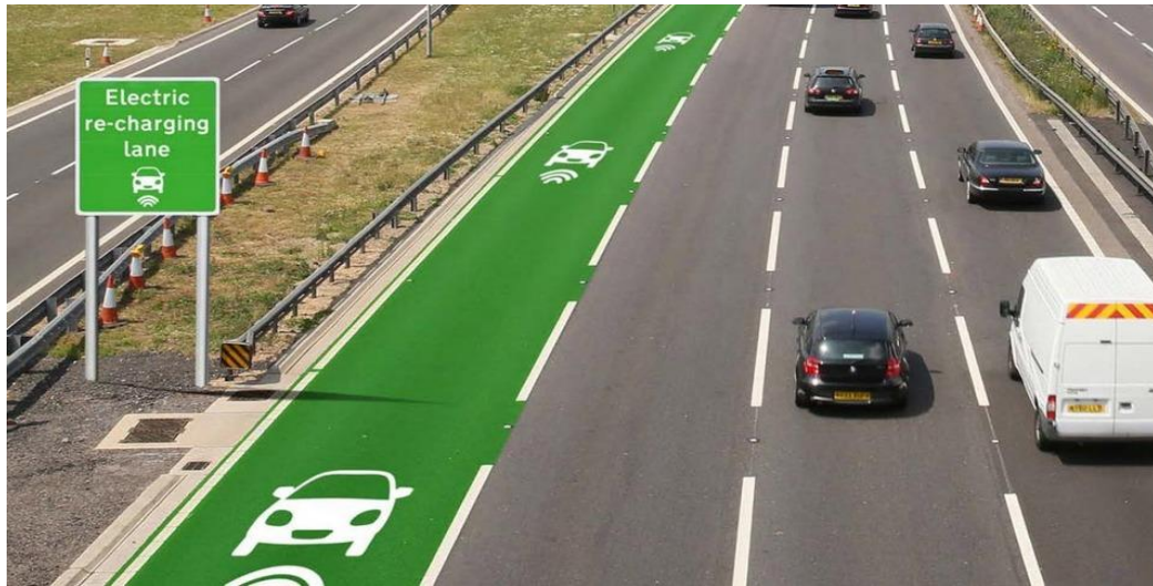
Рис.2.12. Фото дорожного покрытия со встроенными беспроводными зарядными устройствами.
