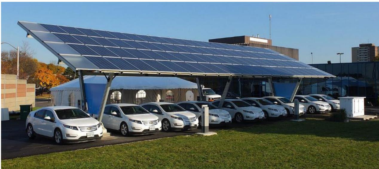
Рис 2. «Солнечная» зарядная станция для электромобилей
