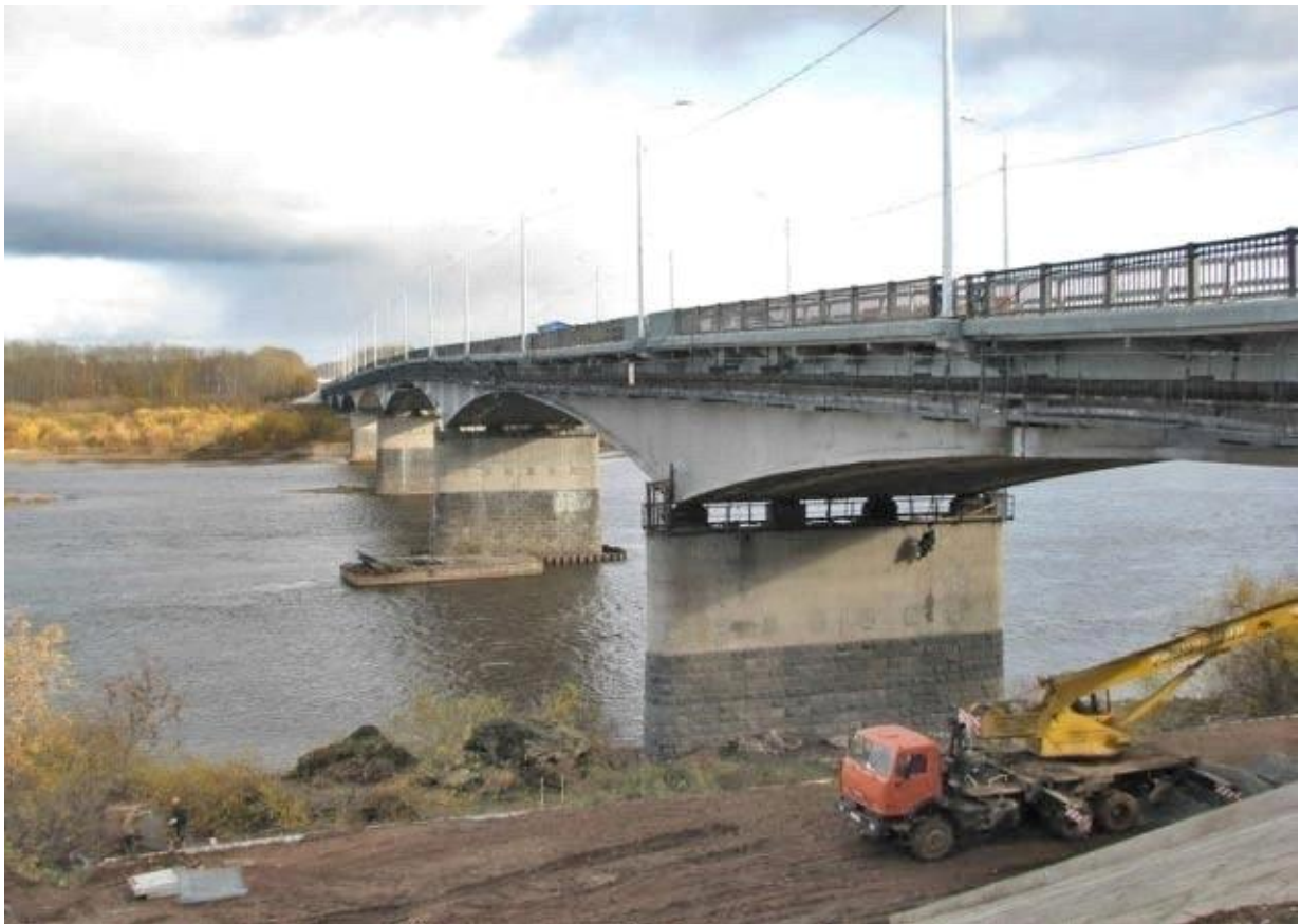
Міст через річку Вятка з дорожньої плитою з легкого наномодефіцірованного бетону
