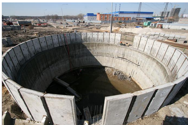
Рис. 3.2 Занурення збірно-монолітного опускного колодязя
