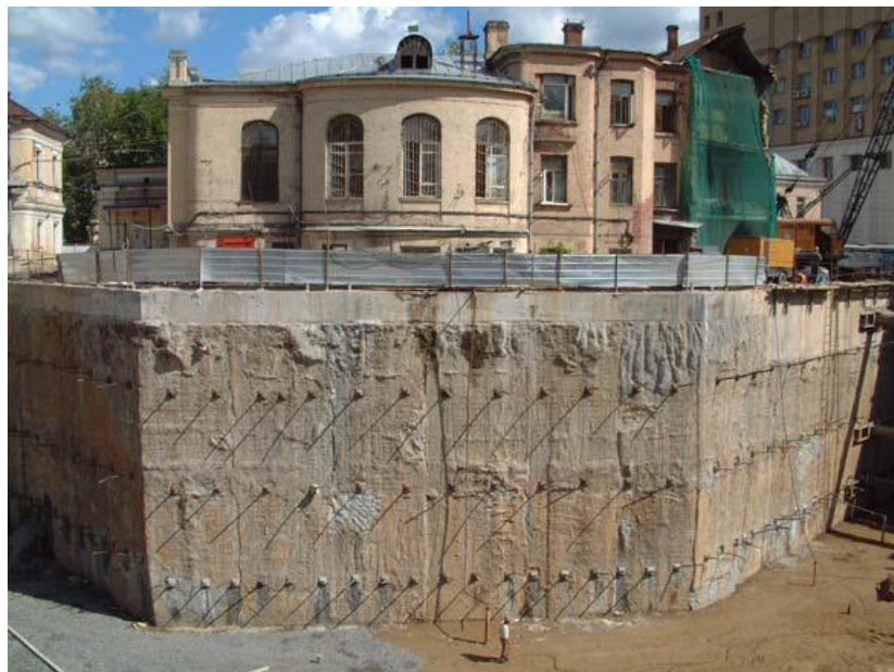
Рис. 3.3 Послідовність пристрою «стіни в ґрунті» - (а);
