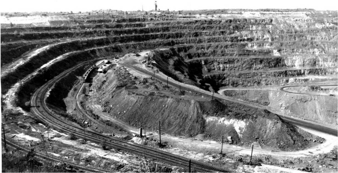
Рис. 4.8. Екскаторний перевантажувальний пункт на кар'єрі №1 НКГЗК (1980 р.)
