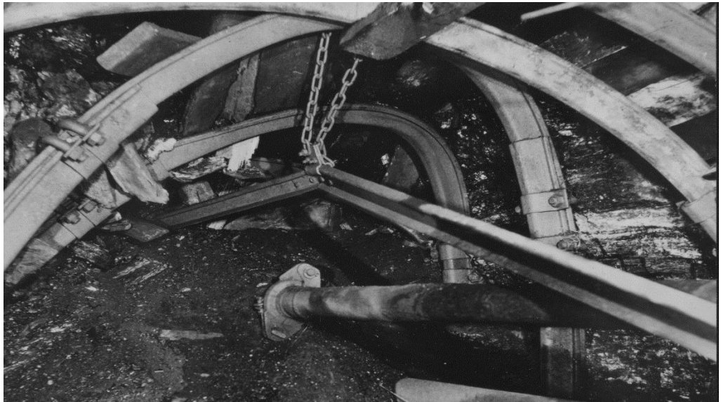
Рис. 2.3 Пример негативного проявления горного давления в протяженных выработках южного крыла шахты «Котляревская» ГП «Селидовуголь»
