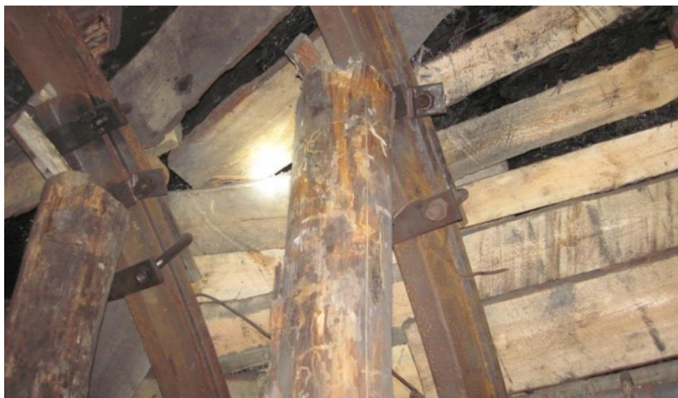
Рис. 2.19- Состояние замков 3-го северного конвейерного штрека пл. 1/ ОП «Шахта «Котляревская ГП «Селидовуголь»
