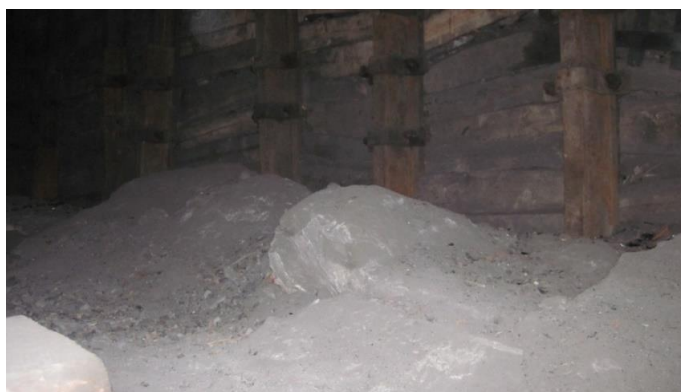
Рис. 2.16- Состояние пород почвы 3-го северного конвейерного штрека пл. 11 :а) искажение профиля рельсового пути; б) формы плит пород, выдавленных из почвы горной выработки
