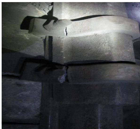
Рис. 2.17- Деформации металлических рам крепи в 3 северном конвейерном штреке пл. 1/1: а) разрыв планки хомута замка; б) выполаживание верхняков, приводящее к такому эффекту
