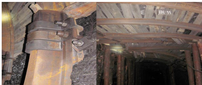
Рис. 2.17- Деформации металлических рам крепи в 3 северном конвейерном штреке пл. 1/1: а) разрыв планки хомута замка; б) выполаживание верхняков, приводящее к такому эффекту
