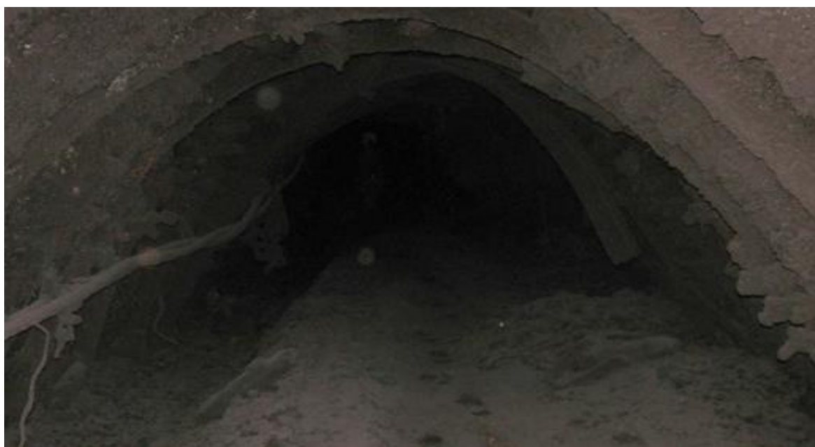
Рис. 2.4 б Пример негативного проявления горного давления в протяженных выработках северного крыла шахты «Котляревская» ГП «Селидовуголь»
