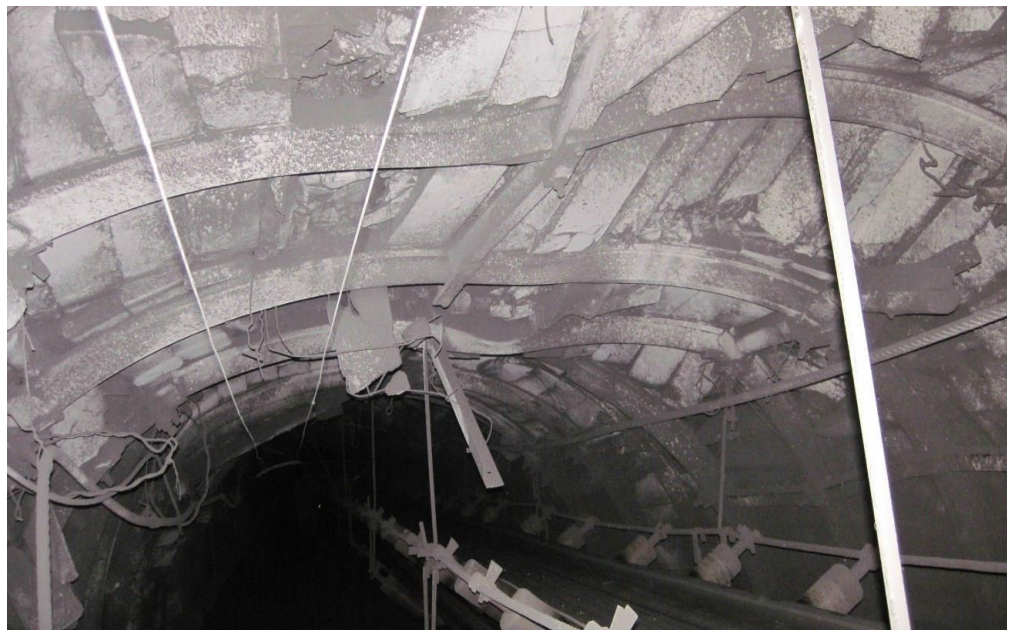
Рис. 2.4 а Пример негативного проявления горного давления в протяженных выработках северного крыла шахты «Котляревская» ГП «Селидовуголь»
