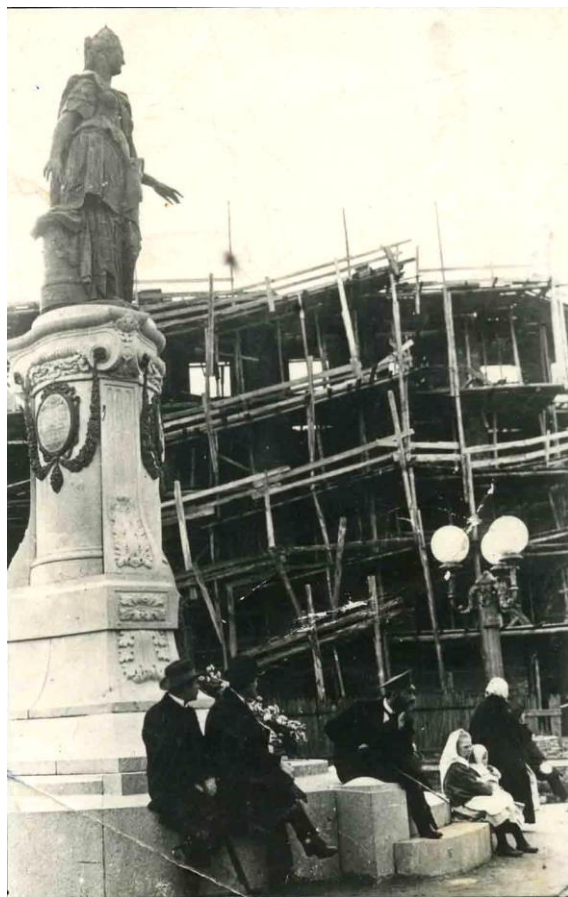
Строительство главного корпуса. На пьедестале - памятник Екатерине II
