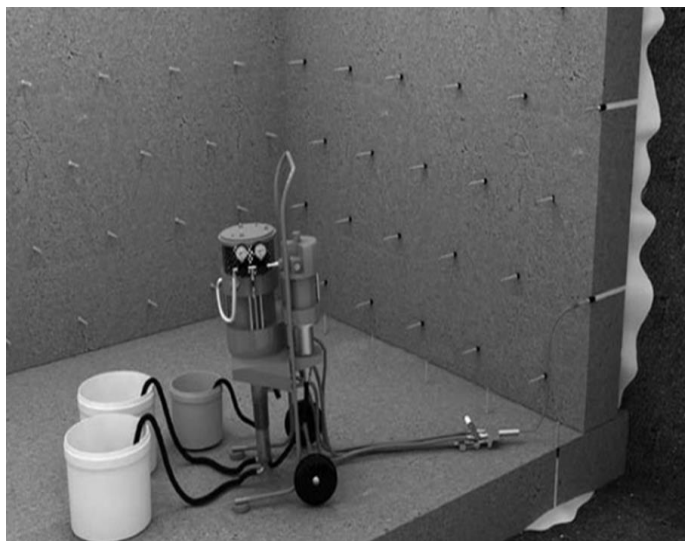
Рис. 1. Проникающая гидроизоляция фундамента: а – общий вид; б – схема
