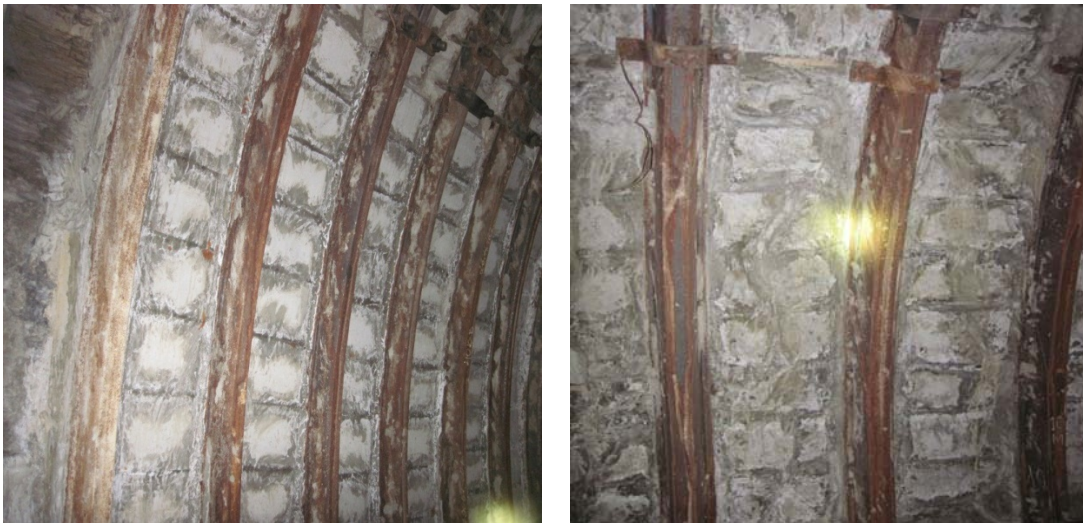
Рис. 2.5. Чеканка стін виробки з деформованою затяжкою
